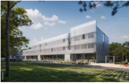
Trois nouveaux bâtiments vont sortir de terre dans les prochains mois.
