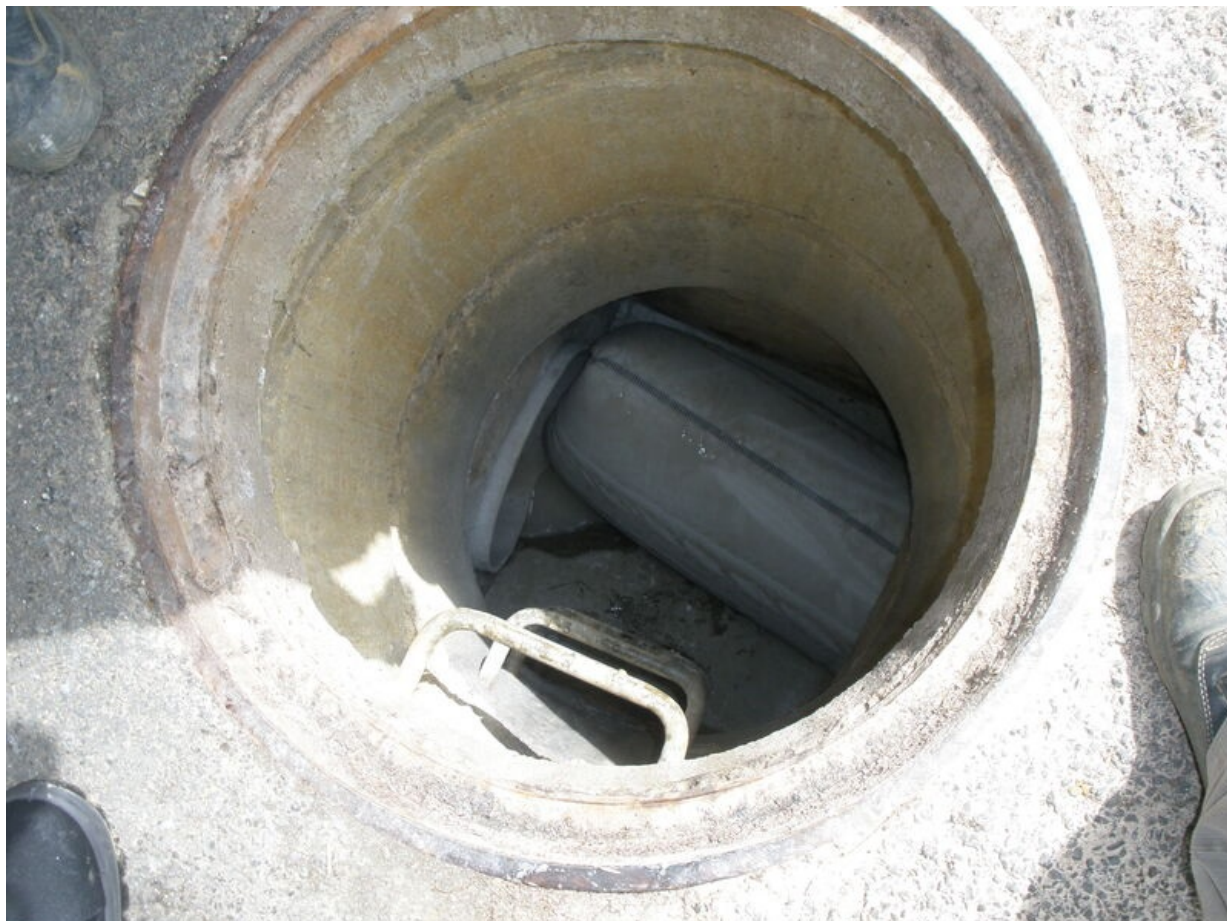
Une nouvelle paroi intérieure est insérée dans les conduites endommagées. © Le Mans Métropole
