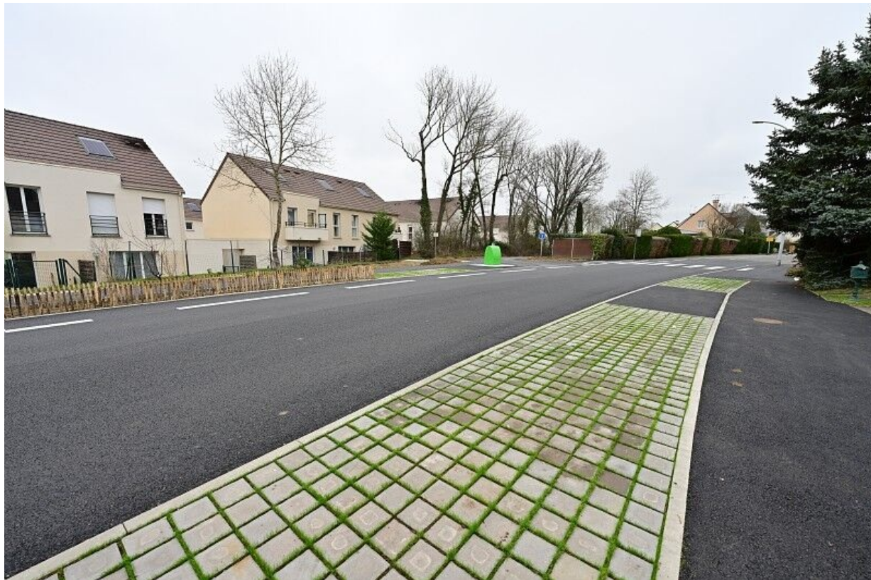
Les eaux de pluie sont infiltrées au niveau des trottoirs. © Ville du Mans
