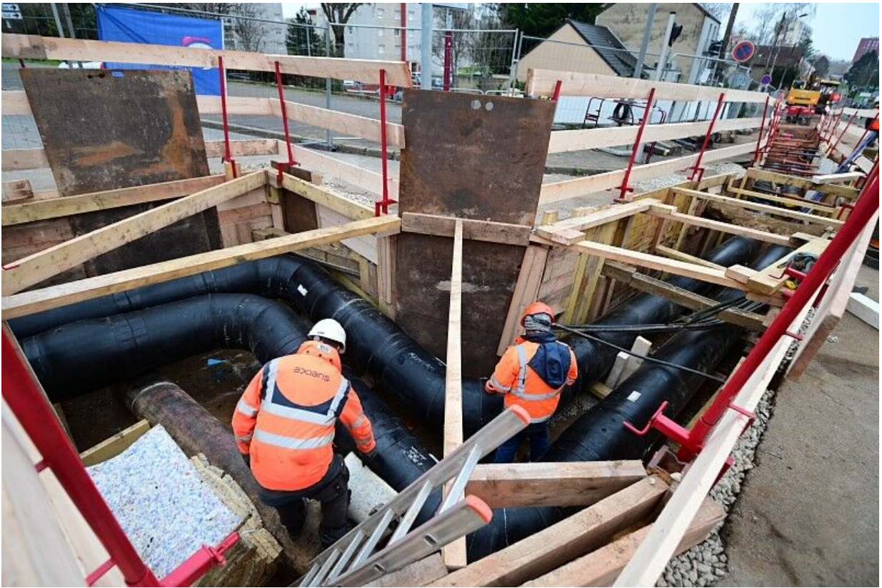
Les travaux d'extension du réseau de chaleur, au Mans. © Le Mans Métropole
