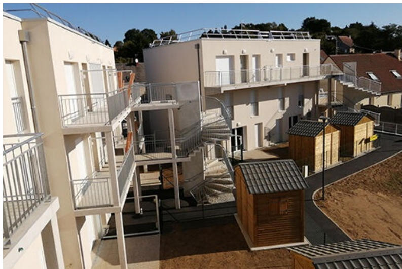
La construction de logements sociaux à la Croix-Georgette, à Allonnes, a bénéficié du programme de renouvellement urbain. © Le Mans Métropole
